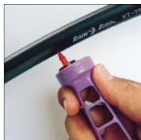
Inserção de Xeri-Bug™ Em Um Passo
